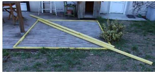
Parafusar (ou montar) 2 pares de 2 peças 4000 mm com um parafuso posicionado a 2200 mm. As duas peças são articuladas.
