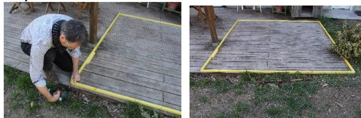
Parafusar (ou montar) as 4 peças de 2200 mm na forma de uma armação. Coloque no chão.
