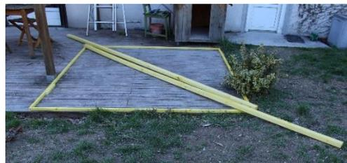
Visser (ou assembler) 2 paires de 2 pièces 4000 mm grâce à 1 vis positionnée à 2200 mm. Les 2 pièces s'articulent.
