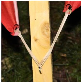
Visser des vis crochets dans les poteaux pour accrocher les voiles.
