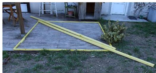
用螺丝钉分别将 2 个长度为 4000mm 的木条装配在地上正方形框架的对角点上
