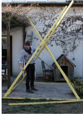
(从第 4 步后) 竖起另外 2 根长度为 4000mm 的木条, 并且用螺丝钉将木条固定在地上正方形框架上
