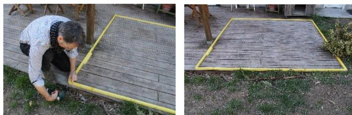
用螺丝钉将 4 个长度为 1400 mm 的木头首尾连接成一个正方形框架放置在地上。
