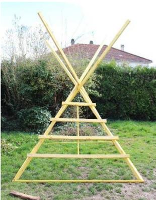
选择接水装置底层一面三角形面安装阶梯, 并用一根木条固定。
